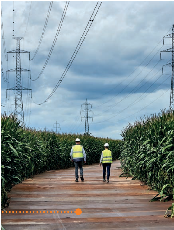
Aanleg van een toegangsweg voor een werf in landbouwgebied
